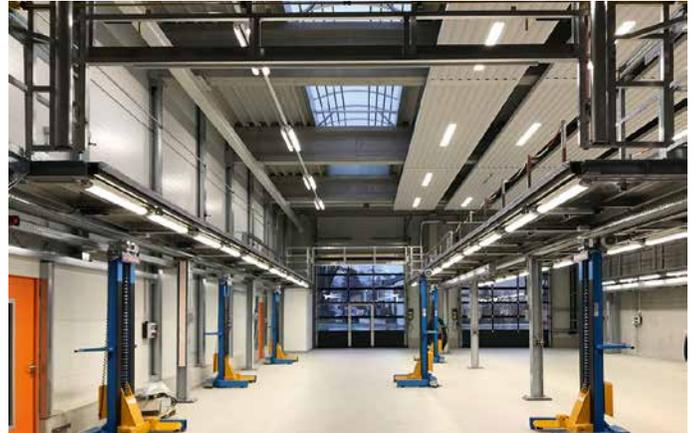
zwei 16 m langen Lichtbändern, Pfosten-Riegel-Konstruktion über 2 Etagen im Bereich Sozialtrakt, Fenster der Werkstätten und Fahrzeughallen mit aufwendigem Kastenrahmen, Toranlage mit Stahlfalttoren und Sektionaltoren, Fundamentierung für hydraulische 6-Stempel-Hebeanlage für zeitgleiche Reparatur an zwei Bussen.
