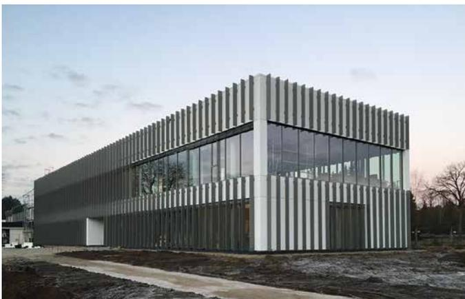
Neubau des Kunden- und Technologiezentrums der Firma Plasmatreat in Steinhagen. Die zweigeschossige Erweiterung mit einer Gesamtfläche von 1.600 m<sup>2</sup> ist an das Bestandsgebäude angeschlossen. Die Konstruktion des Rohbaues ist in Ortbetonbauweise erstellt. Der Schulungsraum im OG ist mit
