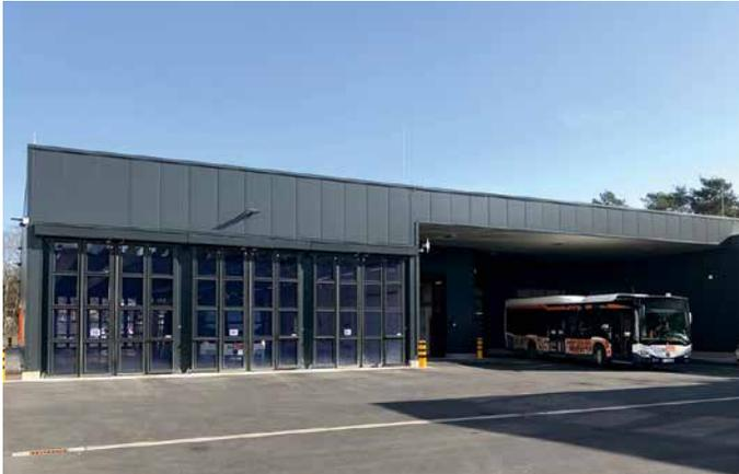
Neubau eines zweiten Busbetriebshofes für den Verkehrsbetrieb moBiel in Bielefeld-Sennestadt. Bau von Werkstätten, Fahrzeughallen, Versorgungs- und Waschhalle, Grundfläche ca. 3.850 m<sup>2</sup>, weiterhin Umbau einer ca. 1.250 m<sup>2</sup> großen Bestandshalle; Hallenkonstruktion in Fertigteilbauweise, Gebäudehülle mit Iso-Fassade, Foliendach, Lichtkuppeln und
