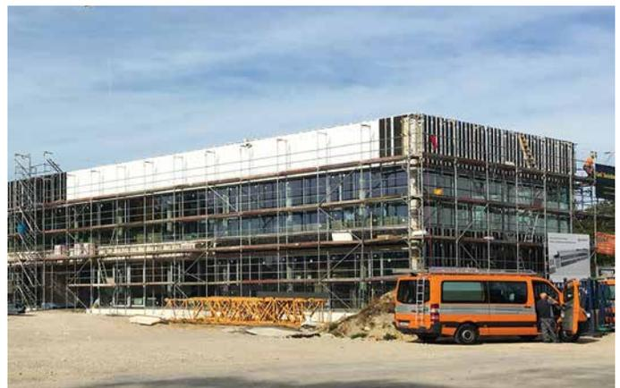
einer 12,50 m weiten, stützenfreien Decke aus Spannbetonhohl- dielen konstruiert. Zum Leistungsumfang der Baugesellschaft Sudbrack gehörten die Dachabdichtungs, Fenster- und Fassadenarbeiten. Besonderheit der Fassade sind die durchgehenden vertikalen Alulamellen als Vorsatz auf der Alucobondfassade.
